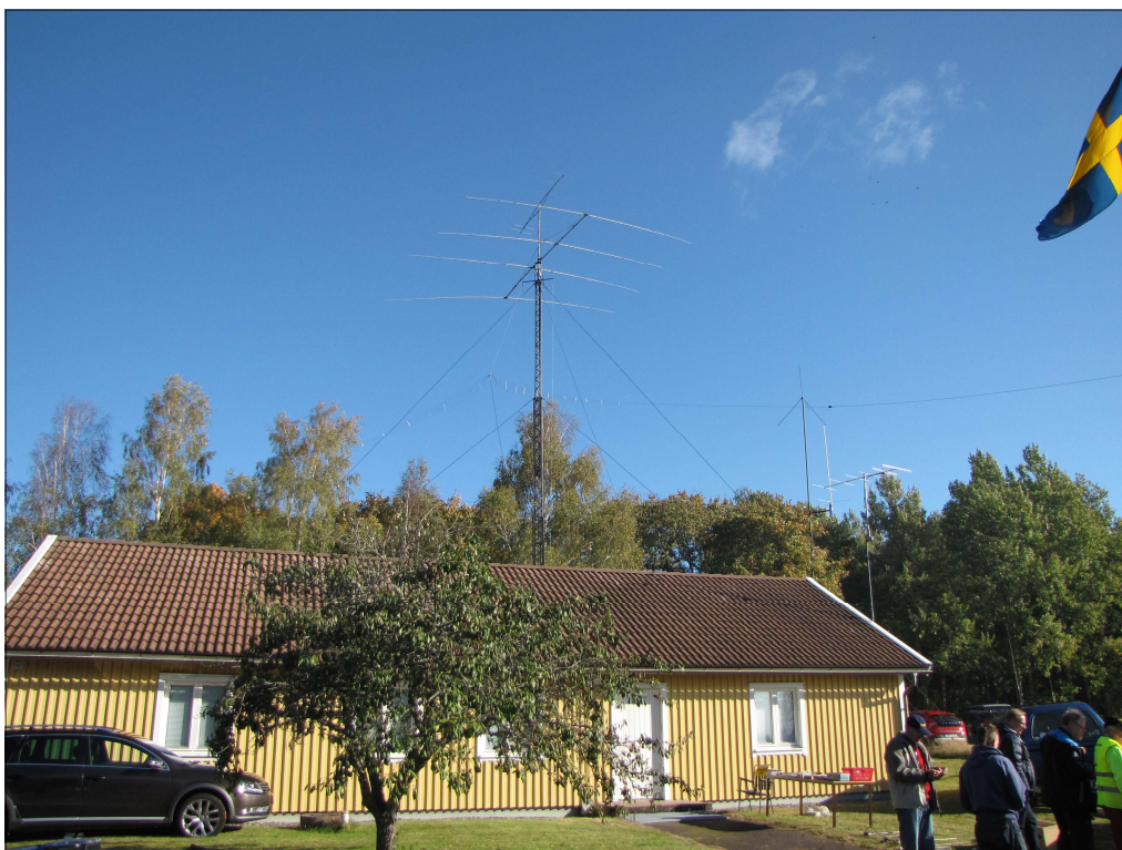
Förlägningsbyggnad med antennfarm.
