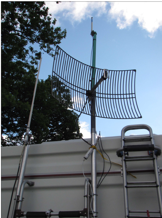
WLAN-antenn - parabol mot Kroksberg och i toppen en liten blindkäpp för lokala Hökås.
