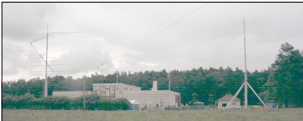
Grimetons radiostation sedd från baksidan. Till vänster en kortvågsantenn och till höger Varbergs Sändaramatörers "portable" mast.
