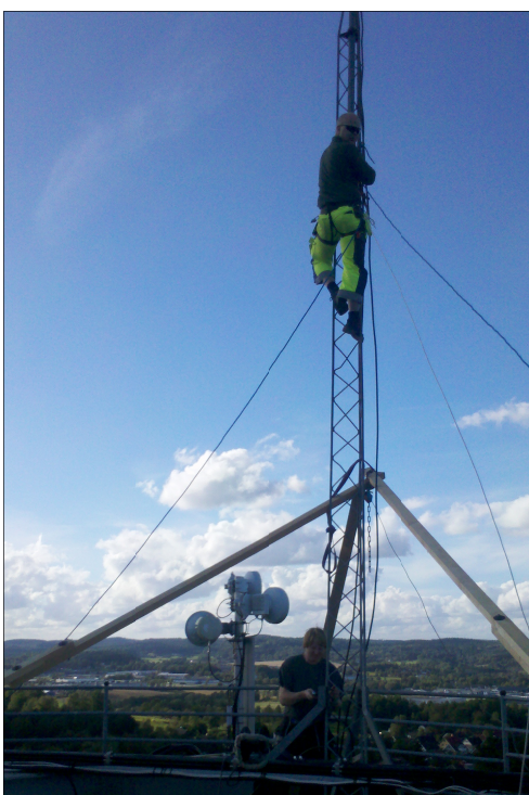
Sven/WOK på väg upp att fästa stödlinorna cirka 45 meter över marken.
